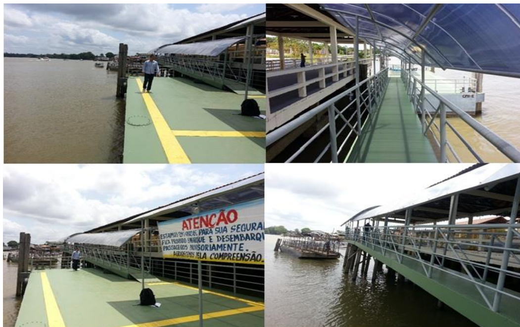
Figura 1 - Terminal hidroviário de Barcarena.
